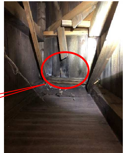
・漏水試験 (散水状況)
