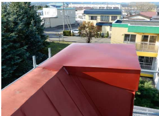
パラペット笠木修復完了
