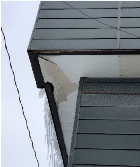
・施工前(春の強風や雨で軒天井材が落下) (2月の保存データ使用)
